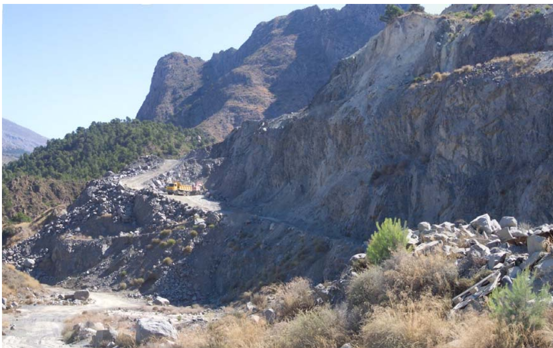
Foto nº 2. Cantera de pórfido en el paraje del Realet.
